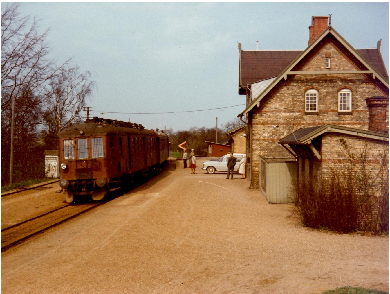
Idyl på Svendborg - Nyborg banen, MP 542 på Hesselager st. i 1964.
